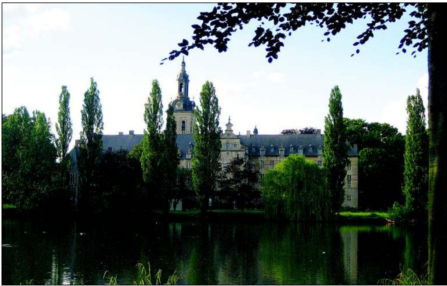
LEUVEN – De Katholieke Universiteit Leuven gaat gebruikmaken van een deel van de Abdy van 't Park. De abdy moet eerst gerestaureerd worden. Een deel van de gebouwen zal gemeenschappelijk worden gebruikt door studenten en norbertijnen. Foto Wikimedia
